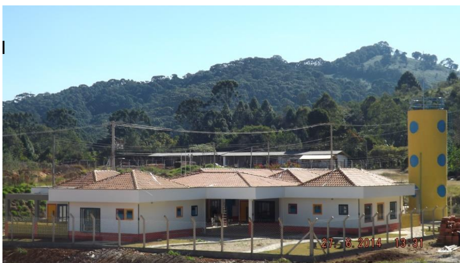
Imagem: Prédio CMEI - Gonçalves/MG
