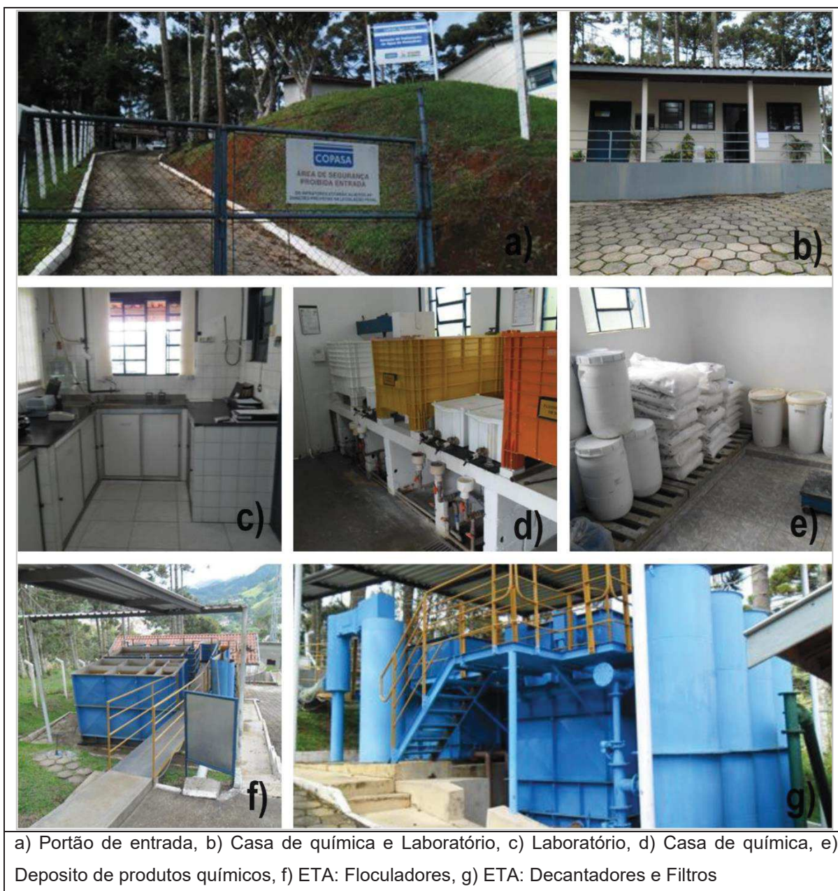
FIGURA 58 – Instalações da ETA do município de Gonçalves.
