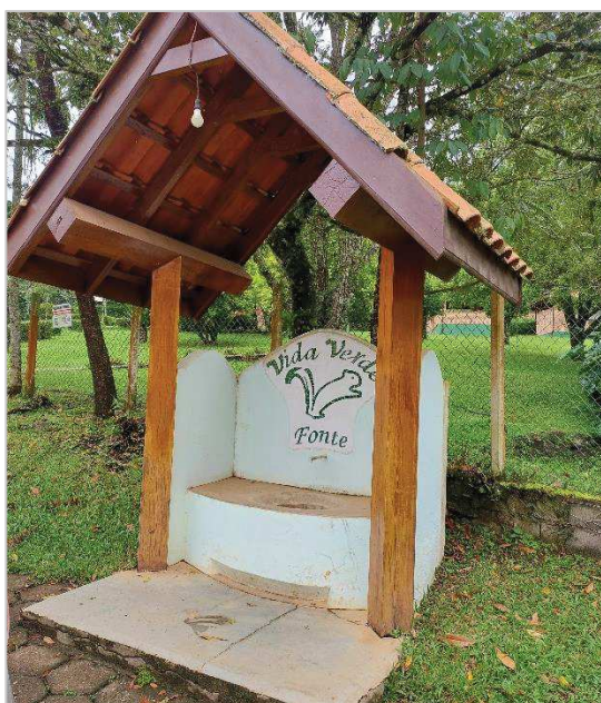
FIGURA 51 – Fonte de água situada às margens de uma estrada municipal, interdita por falta de potabilidade
