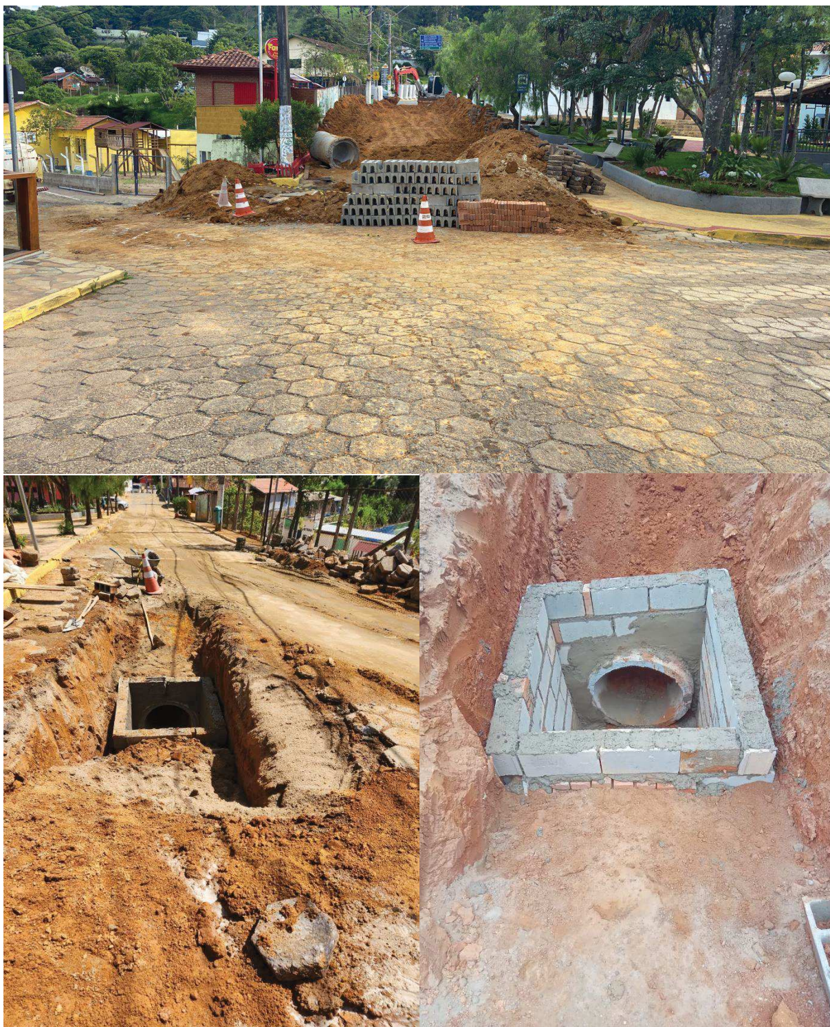
FIGURA 120 – Obras de drenagem pluvial implantado por empreendedor de loteamento
