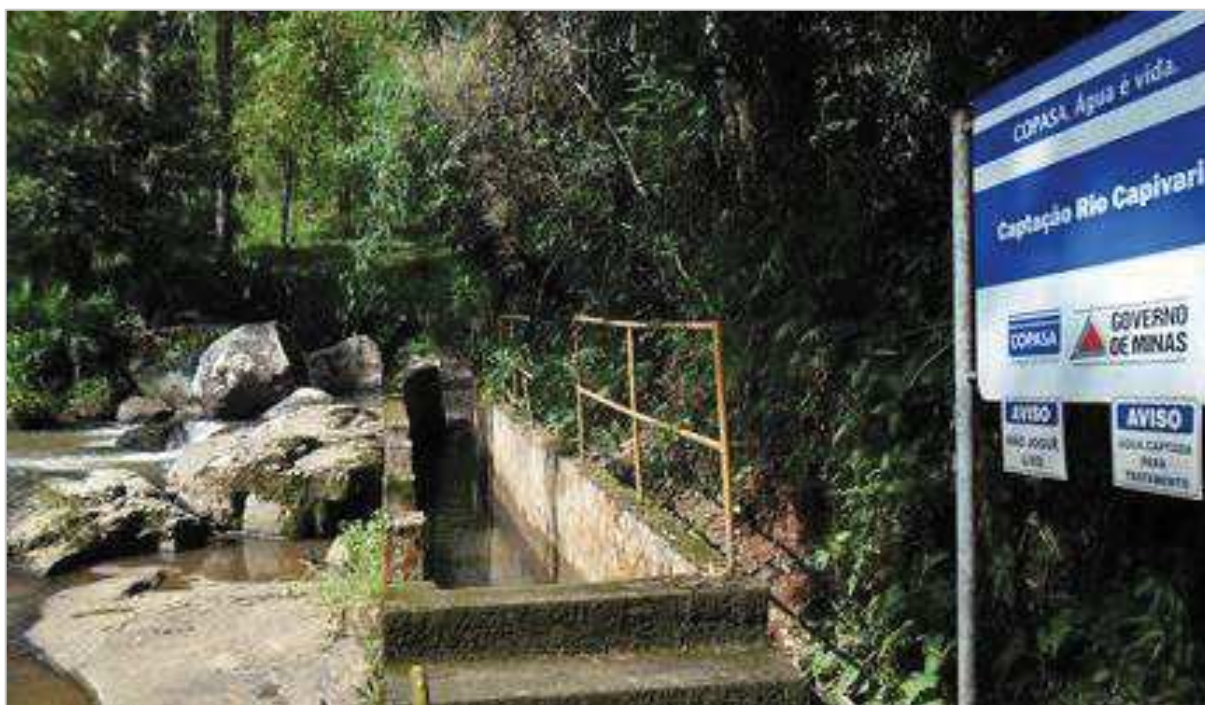
FIGURA 56 – Desvio construído para captação
