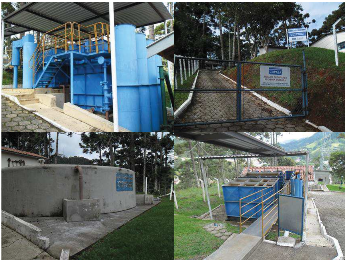
FIGURA 97 – Local da geração de lodo proveniente do tratamento de água para abastecimento de Gonçalves
