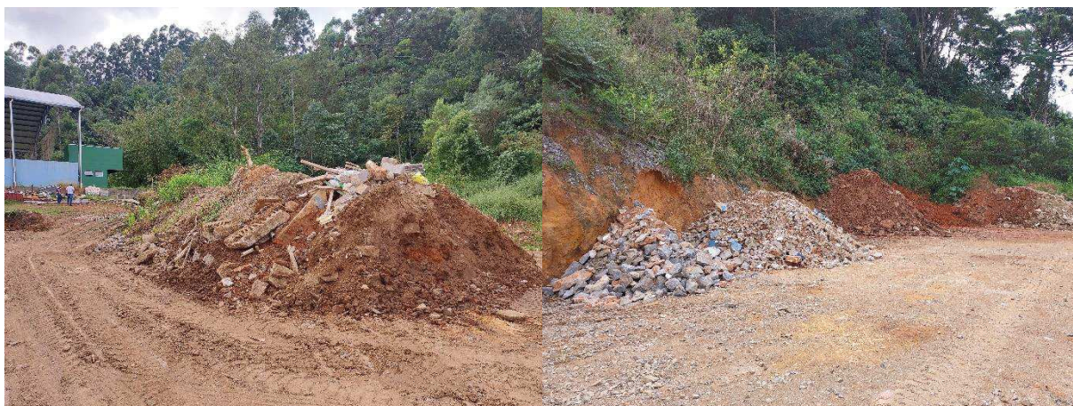
FIGURA 103 – Armazenamento temporário de RCC
