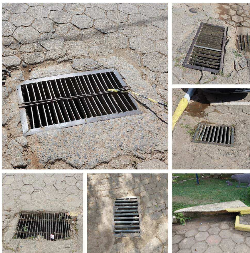
FIGURA 118 - Bocas de lobo encontradas na área urbana de Gonçalves
