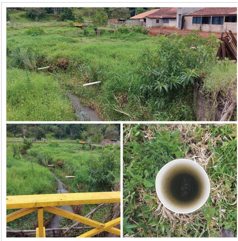
FIGURA 71 – Lançamento de esgoto sanitário da comunidade Atrás da Pedra
