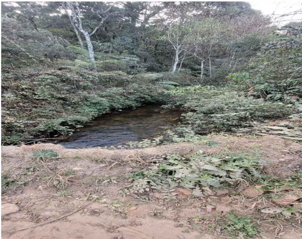
Ponte de acesso Bairro Campestre
